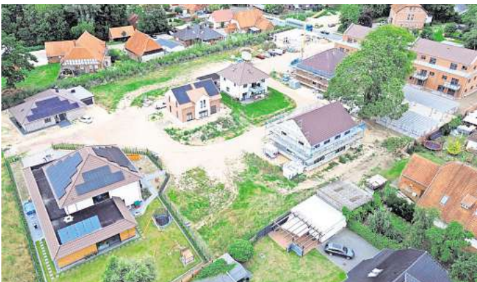
Was sich so alles tut im Baugebiet „Zur Krone“ in Holtorf, verdeutlicht dieses Drohnfoto. FOTO: EDDA HAGEBÖLLING
