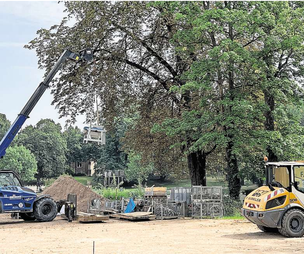
An der Oyler Straße in Nienburg wird gebaut. FOTO: MANON GARMS
