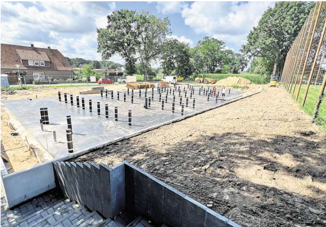
Direkt am Sportplatz lassen die Johanniter die neue Kita in Stöckse bauen.
