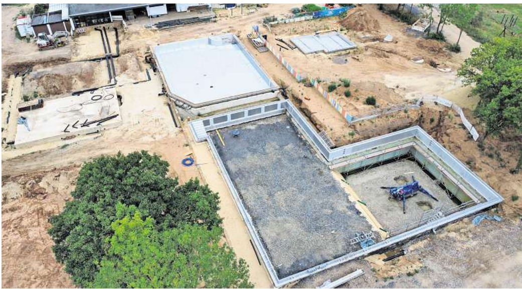
Blick aus der Baustelle: So sind die Becken im Freibad in Stolzenau künftig angeordnet.
