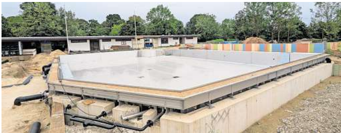
Das Nichtschwimmerbecken ist angeschlossen.
