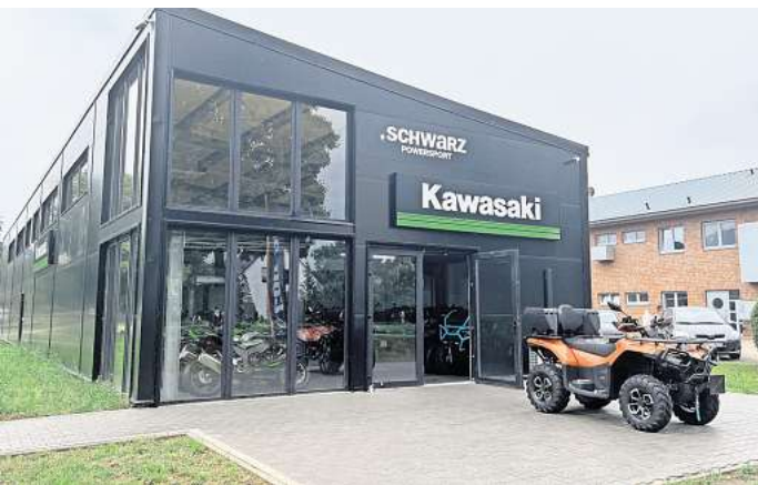
Die neue Halle.
