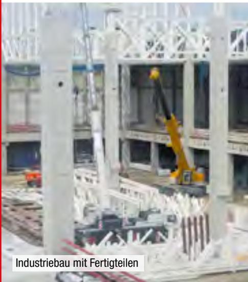
Industriebau mit Fertigteilen
