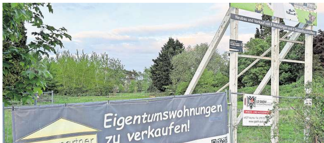
Hier sollen neue Häuser gebaut werden.
