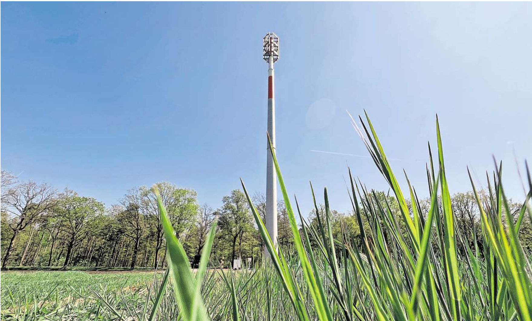
Der Mobilfunk-Mast zwischen Husum und Rehburg.
