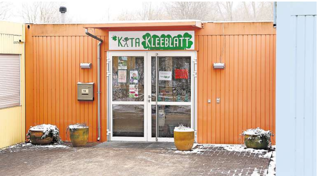
Die Container-Kita Kleeblatt ist saniert worden.
