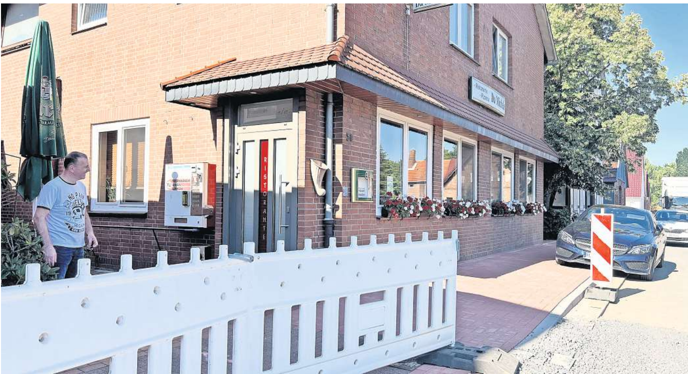
Seit knapp zwei Jahren wirkt sich die umfassende Straßensanierung mit teils falschen und irreführenden Google-Angaben zur Erreichbarkeit der Pizzeria aus.
