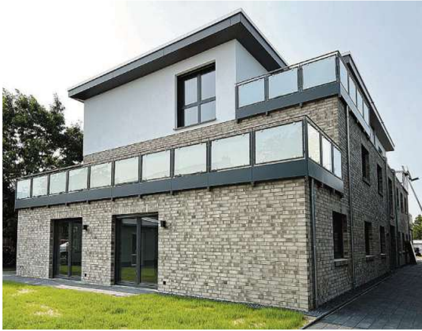
Der Neubau an der Kleinen Ziegelriede.
