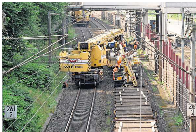
Erst mal wird's schlimmer: Wegen Bauarbeiten zwischen Hamburg und Berlin – wie hier in Schleswig-Holstein im Sommer 2024 – müssen die Züge ab August für mindestens neun Monate Umwege fahren. FOTO: MARCUS BRANDT/DPA
