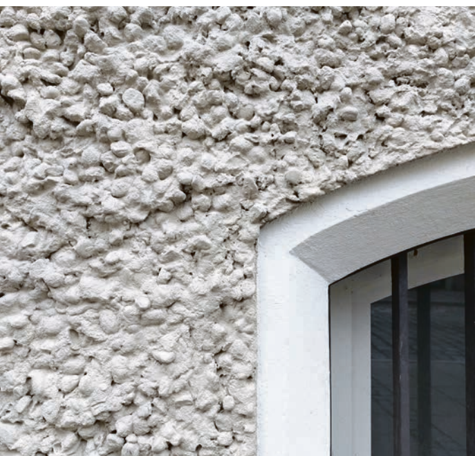
Grobe Putzstrukturen schaffen einen unverwechselbaren Look für die Außenhülle des Gebäudes. Foto: DJD/VDPM
