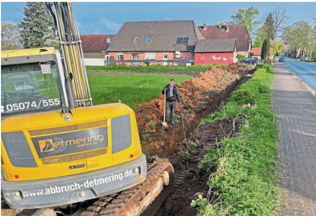
Der Nahwärmenetzausbau in Rodewald schreitet voran.
