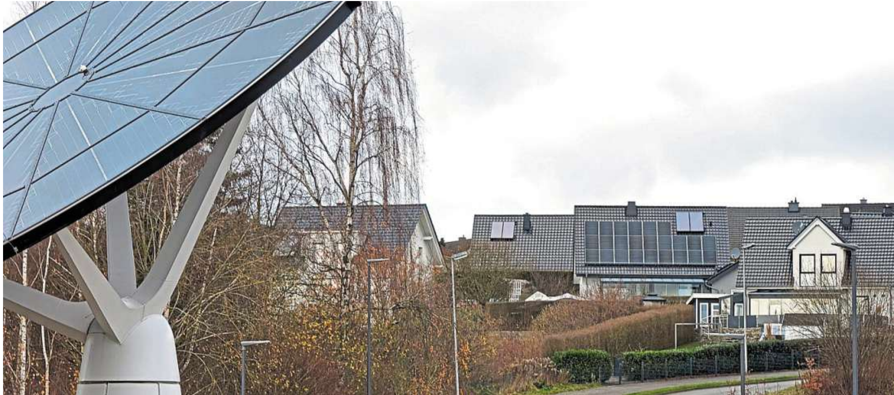
Seit dem 1. Januar gilt in Niedersachsen eine umfassende Pflicht zur Installation von Photovoltaikanlagen auf allen neuen Gebäuden sowie bei Veränderungen an bestehenden Dächern.
