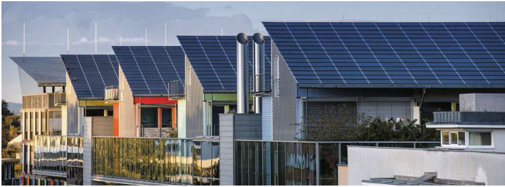
Das Interesse an Photovoltaik-Anlagen ist in Deutschland weiterhin sehr groß, am besten fahren Haushalte, wenn sie sich ein komplettes Solarpaket zulegen. Foto: DJD/LichtBlick SE/Gyula Gyukli/Fotolia
