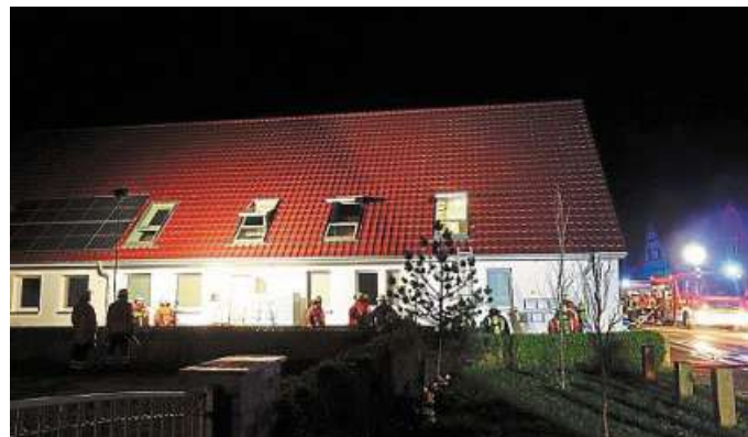
Fünf Menschen werden bei einem Brand in Diepenau verletzt.
