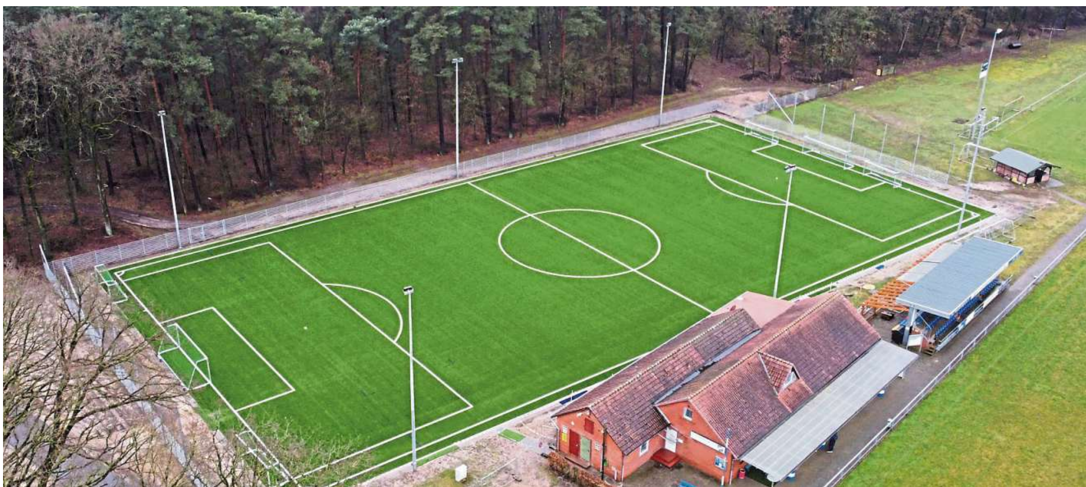
Der Haßberger Kunstrasenplatz ist fertiggestellt.
