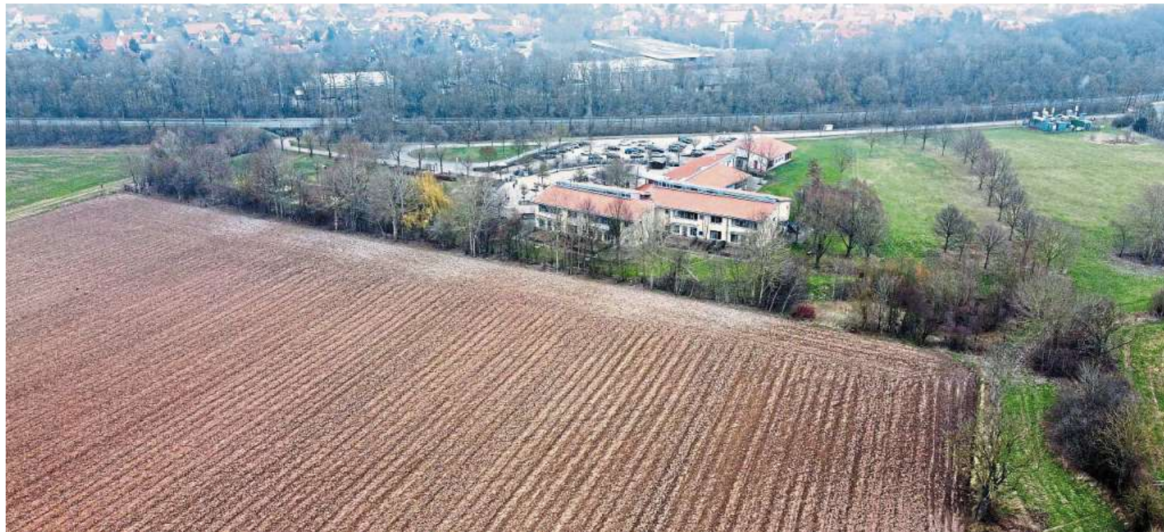
Im Bereich „Hinterm Damme“ soll der Oberschulneubau in Nachbarschaft zur Grundschule gebaut werden.
