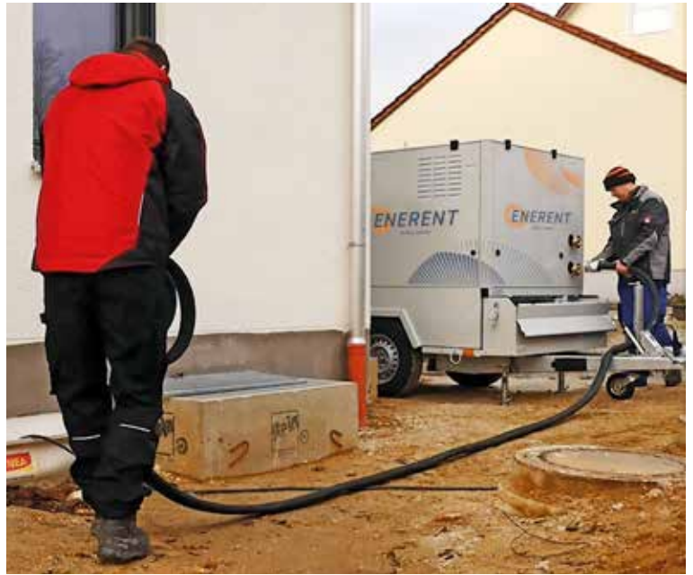
Eine gemietete Heizung wird auf einem fahrbaren Anhänger zur Baustelle gefahren.
