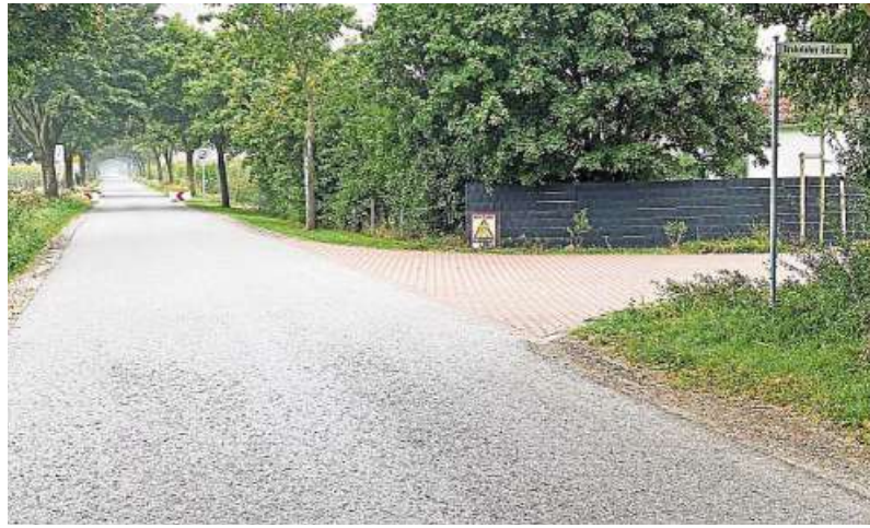
Die Ortseinfahrt nahe des Brokeloher Hellbergs wurde verengt (Hintergrund).
