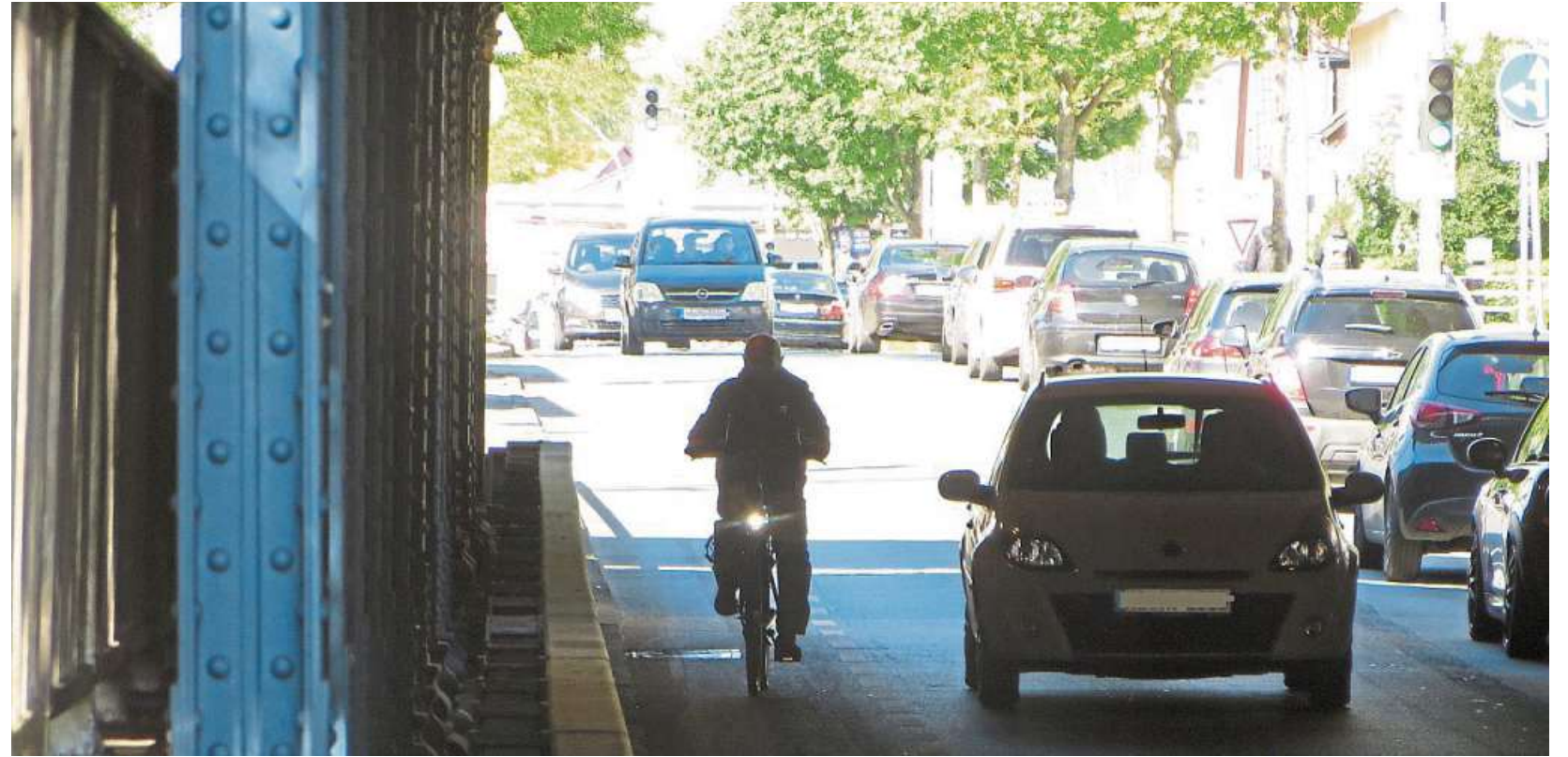
Für viele Radfahrer ein Graus: die Durchfahrt durch den Tunnel Verdener Straße.
