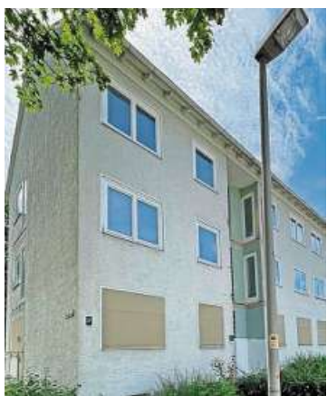
Stehen leer: Die Häuser sollen zur Flüchtlingsunterkunft umgebaut werden. FOTO: CONRAD VON MEDING
