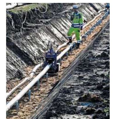
Teuer: Bau einer Stromtrasse unter der Erde. FOTO: C. REHDER/DPA
