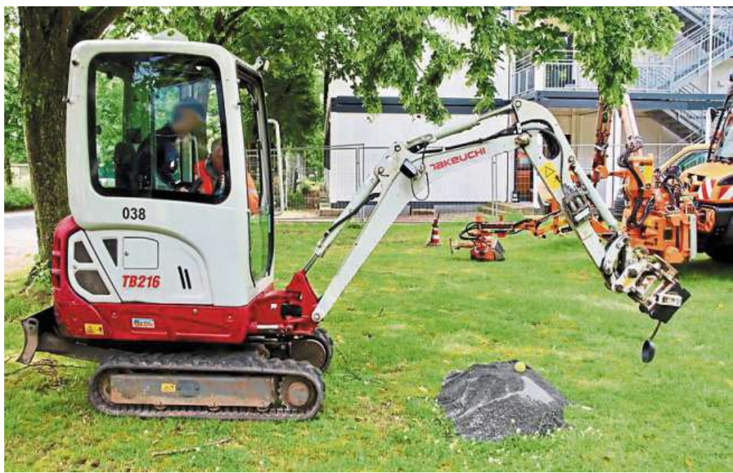
Die Firma Gross Asphaltbau war mit einem Kleinbagger in Marklohe vor Ort.
