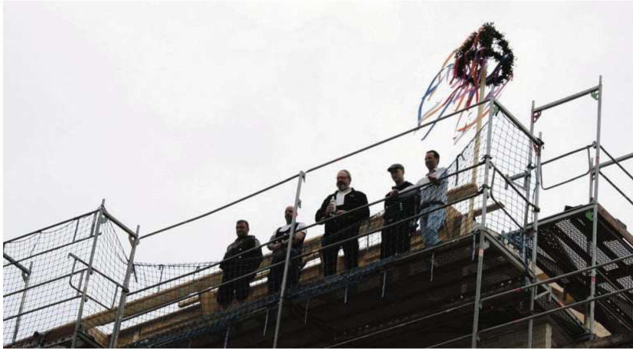
Am 3. Mai fand das Richtfest statt. Foto: Duensing
