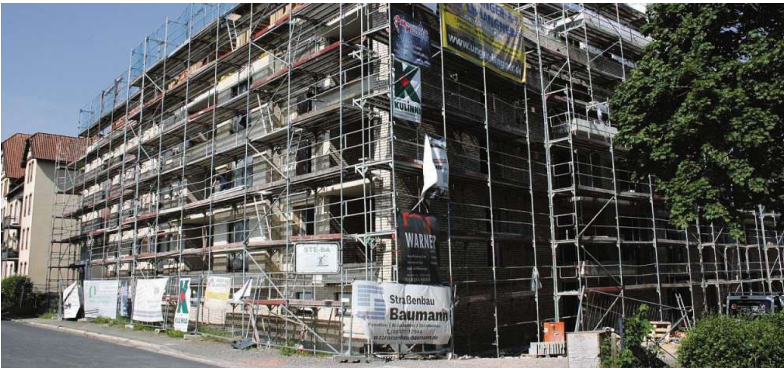
Die Bauphase läuft auf Hochtouren.
