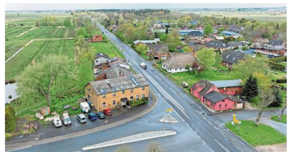
Die norddeutsche Senioren-WG „Haus Schmidt“ liegt direkt an der Durchfahrtsstraße. Früher befand sich in dem gelben Gebäude die Gaststätte des Ortes.
