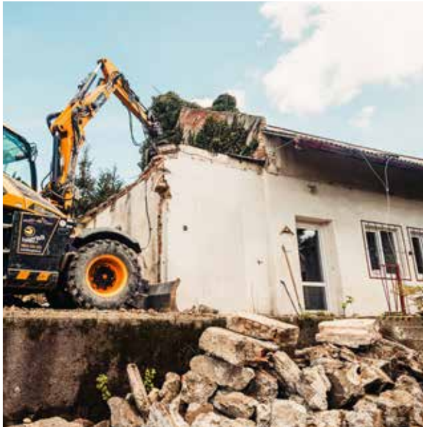
Bei einem Hausabriss ist eine Menge zu beachten.
