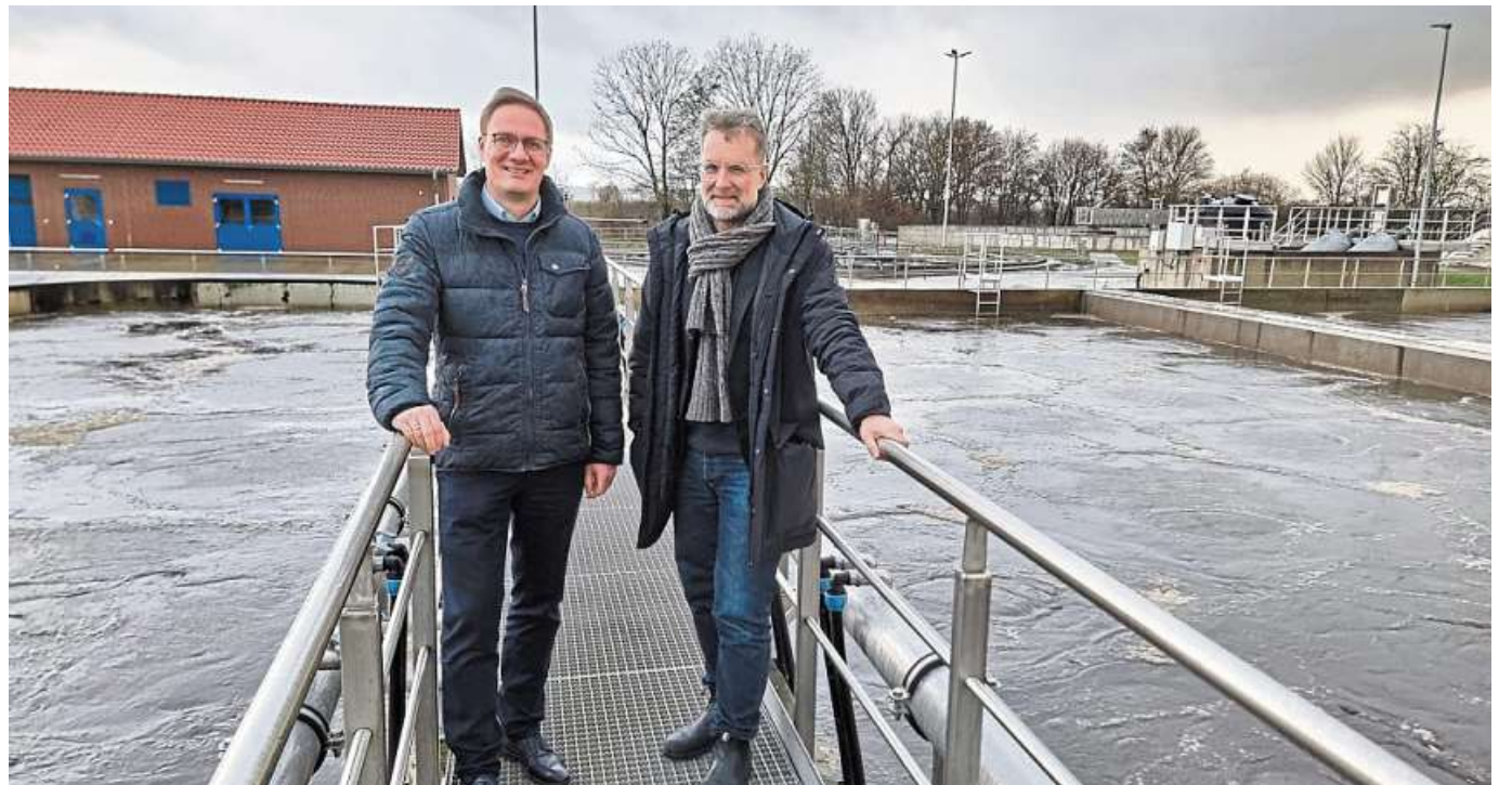
Gaylord Kurre, Geschäftsführer des Kreisverbandes für Wasserwirtschaft (links), und Thomas Breer, Geschäftsführer der Stadtwerke Nienburg und der Nienburg Energie, auf der Arbeitsbrücke des Belebungsbeckens der Kläranlage Drakenburg.
