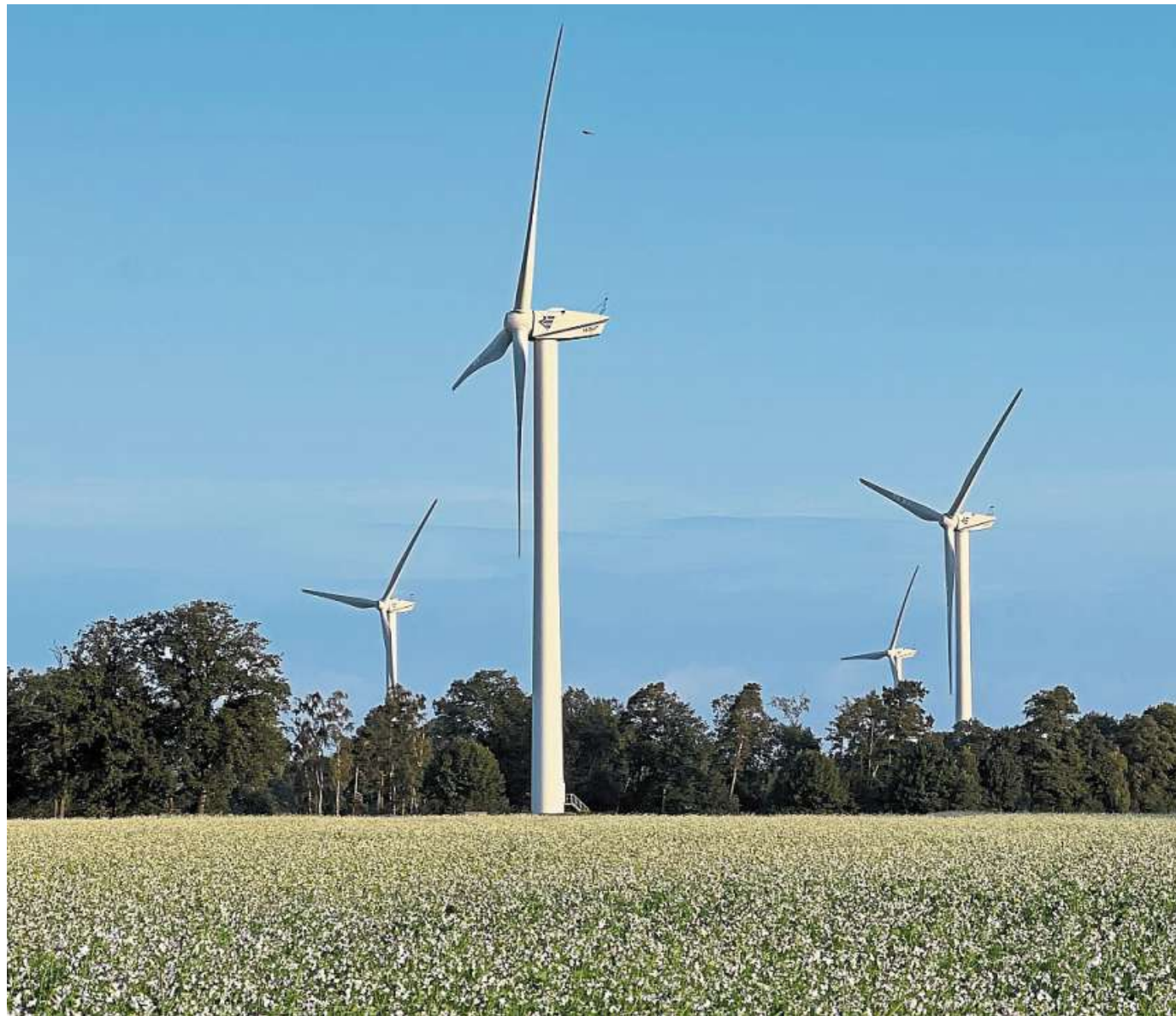
In der Samtgemeinde Heemsen soll im ersten Step eine Fläche von 99,4 Hektar für Windkraft ausgewiesen werden. Der Entwurf sieht vor, am Auering in Haßbergen 54,3 Hektar und bei Gadesbünden (Foto) 45,1 Hektar einzuplanen. FOTO: HAGEBÖLLING
