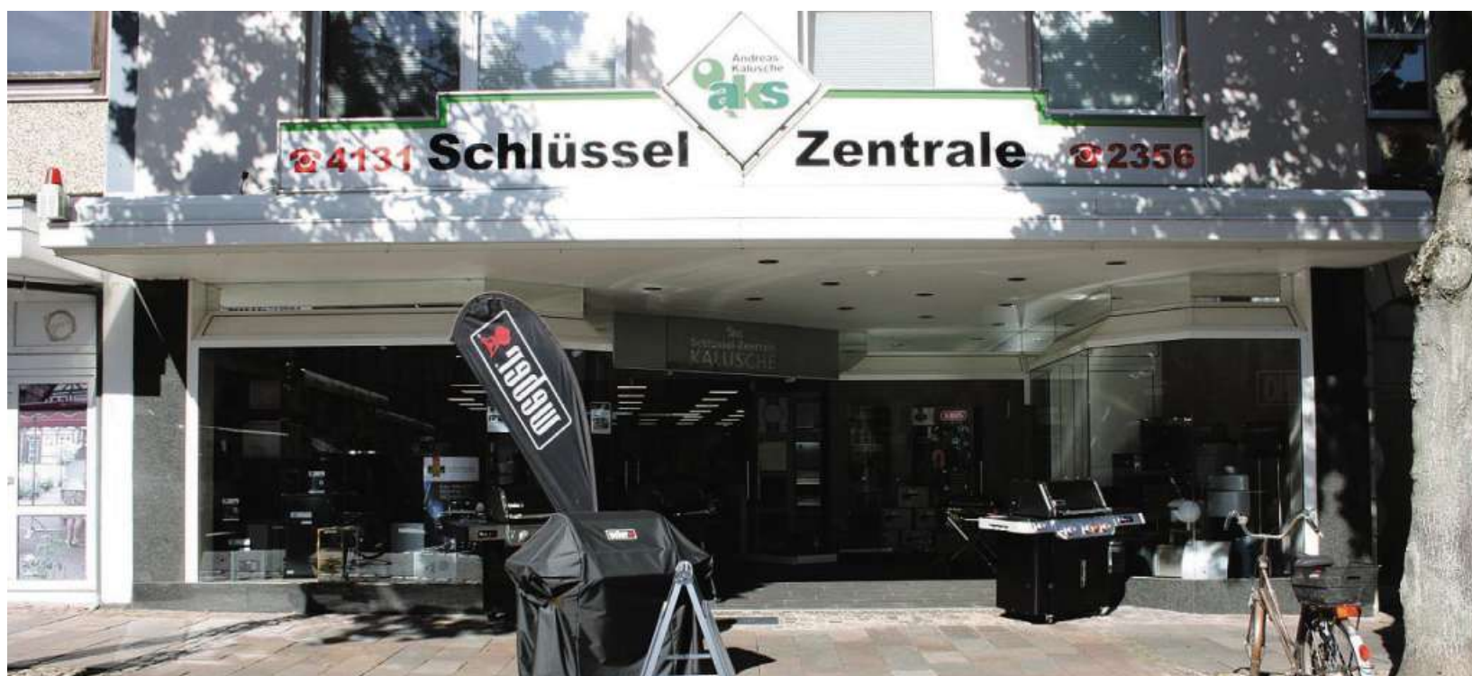
Die „aks“-Schlüsselzentrale an der Langenstraße 35 in Nienburg.
