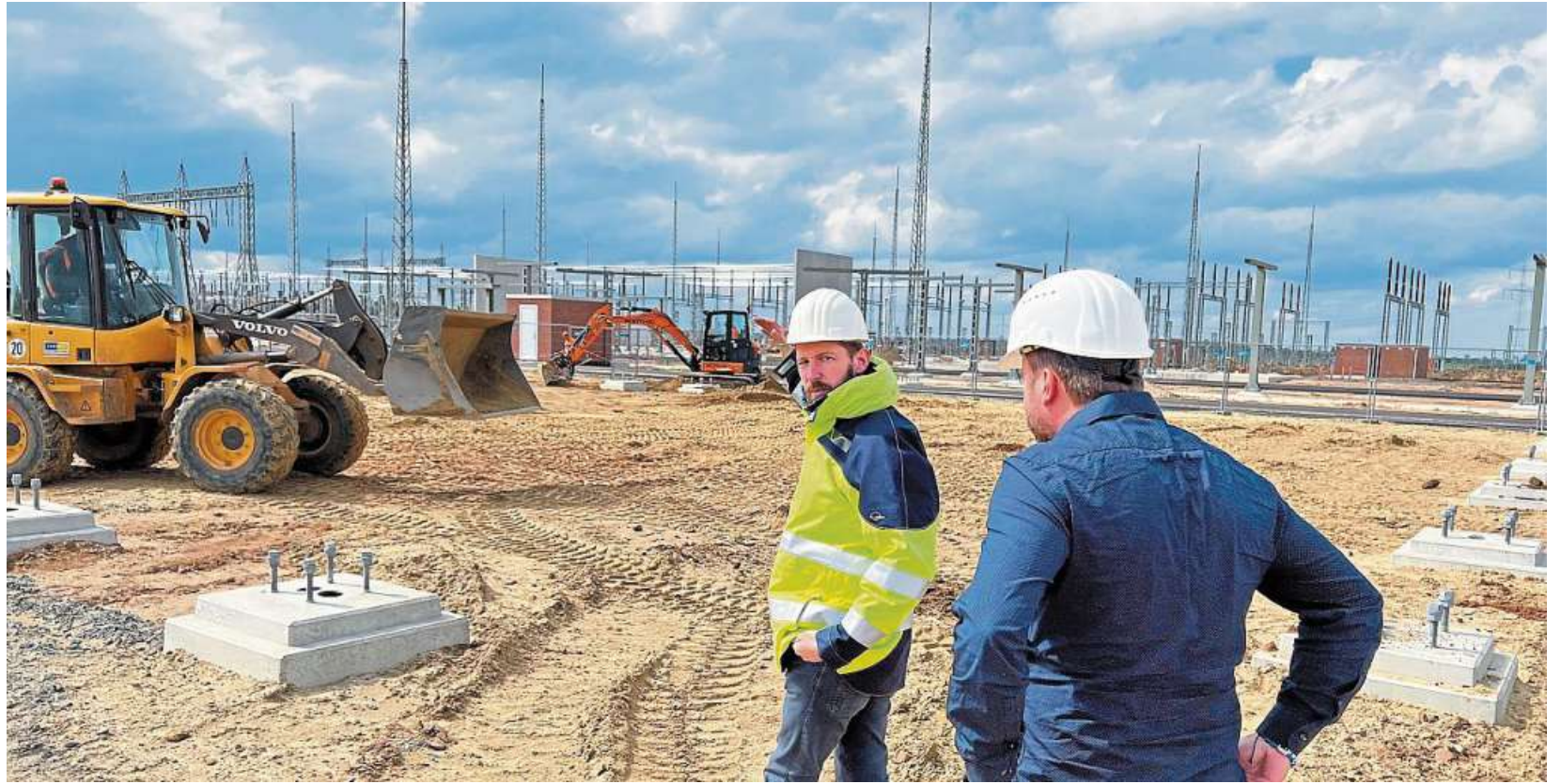
Avacon-Kommunalreferent Johannes Schlemmermeyer (links) und Projektleiter Alexander Weber auf der Baustelle.
