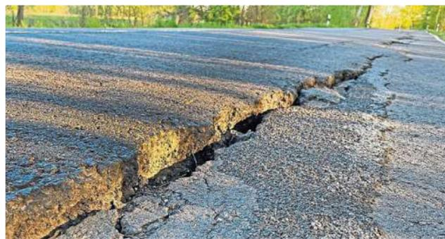
Bis zu zehn Zentimeter Höhenunterschied bedeuteten Lebensgefahr für Biker: Mittlerweile sind die schlimmen Abrisse wieder mit frischem Asphalt begradigt.
