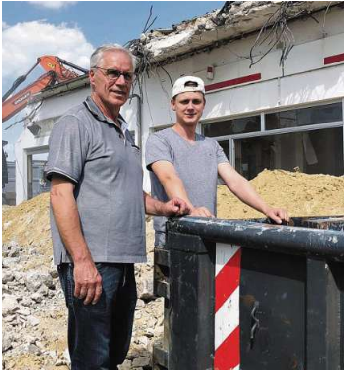
So sah es vor Monaten aus: Werner und Philipp Cunow während der Abbrucharbeiten. Foto: Schwiersch
