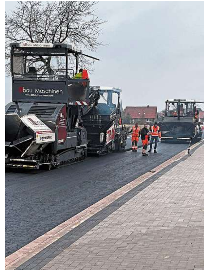
Der rund 650 Meter lange dritte Unterabschnitt des zweiten Bauabschnitts der Kanalsanierung Leese ist abgeschlossen. Anfang der Woche wurde der Asphalt eingebaut.
