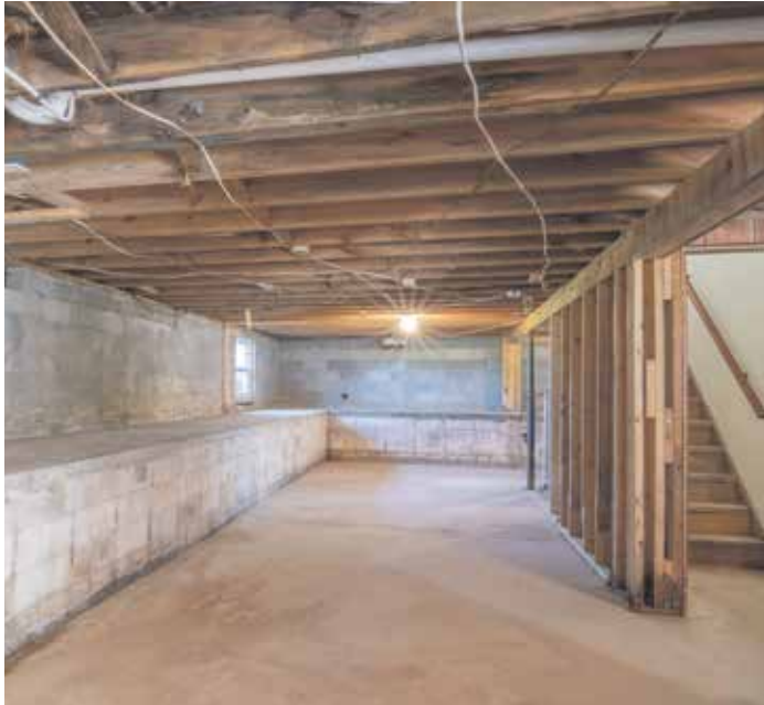
Ein Kellerausbau hat viele Vorteile: Viel Platz ist einer davon.
