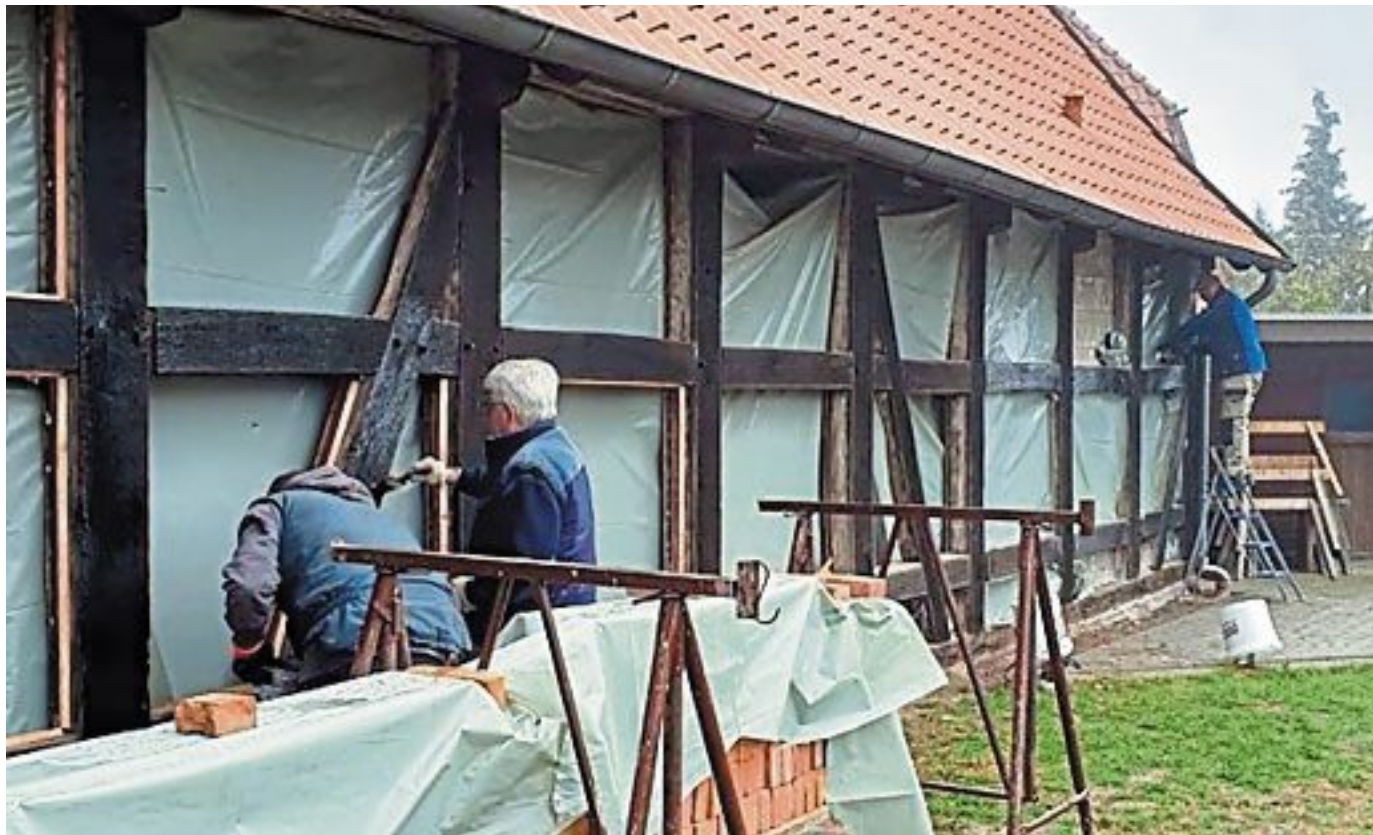
Die Arbeiten an der Olen Schöne in Drakenburg schreiten zügig voran. Zur Wiedereröffnung soll die Ausstellung „Ole Schöne im Wandel der Zeit“ gezeigt werden. Dafür werden alte Fotos und ähnliches gesucht. FOTO: HEIMATVEREIN DRAKENBURG
