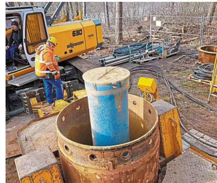
In Liebenau wird ein neuer Brunnen gebohrt. FOTO: WASSERVERBAND
