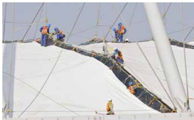
Im Einsatz: Arbeiter befestigen die Dachkonstruktion des Khalifa International Fifa Stadium westlich von Doha.
