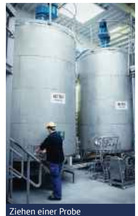
Ziehen einer Probe
