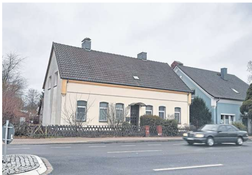
Das Haus Verdener Landstraße 65 soll in eine Krippengruppe umgebaut werden.
