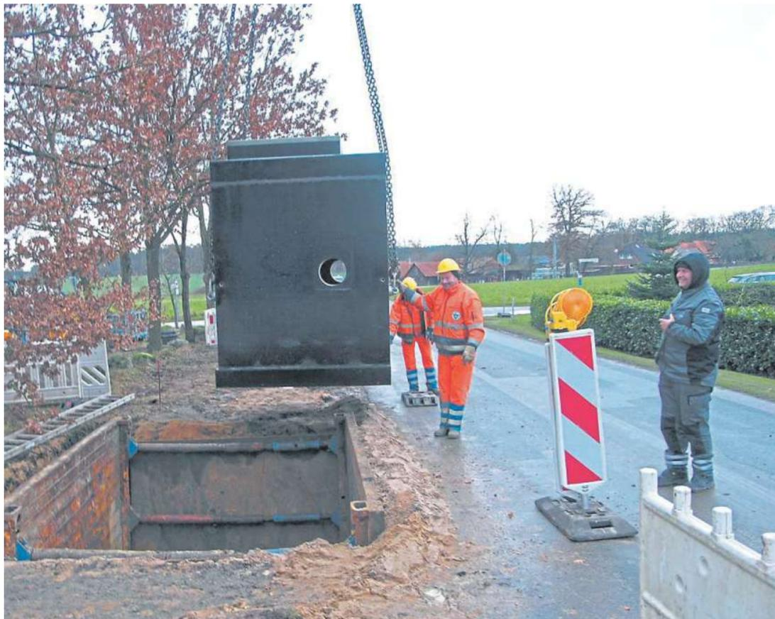
Die Arbeiten am ehemaligen „Wiesenhof“-Betriebswasserwerk in Holte und dessen Einbindung ins öffentliche Netz sind fast abgeschlossen. Zuletzt kamen drei je 14 Tonnen schwere Armaturenschächte mit großen Druckregelventilen in die Erde. Am 15. Februar soll das „neue“ Wasserwerk ans Netz gehen.
