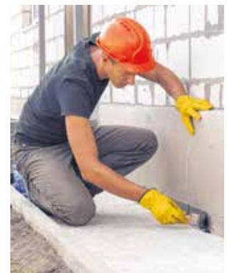
Vor allem im Sockelbereich sollten Keller- und Außenwände wasserdicht abgeschirmt sein.
