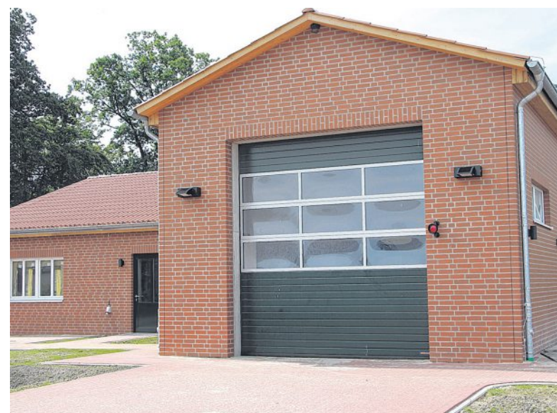
Das neue Feuerwehrhaus ist ein beliebter Treffpunkt in Anderten.
