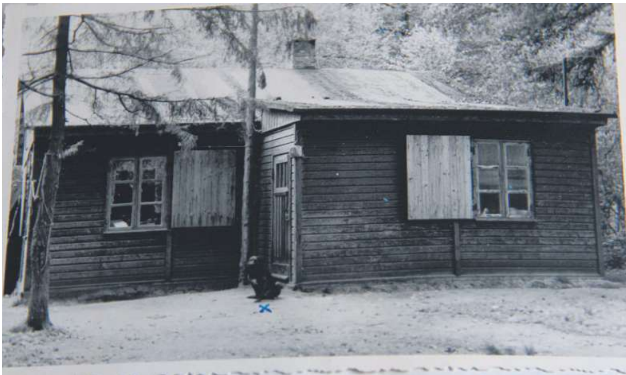
Das Behelfshäuschen in Borstel.
