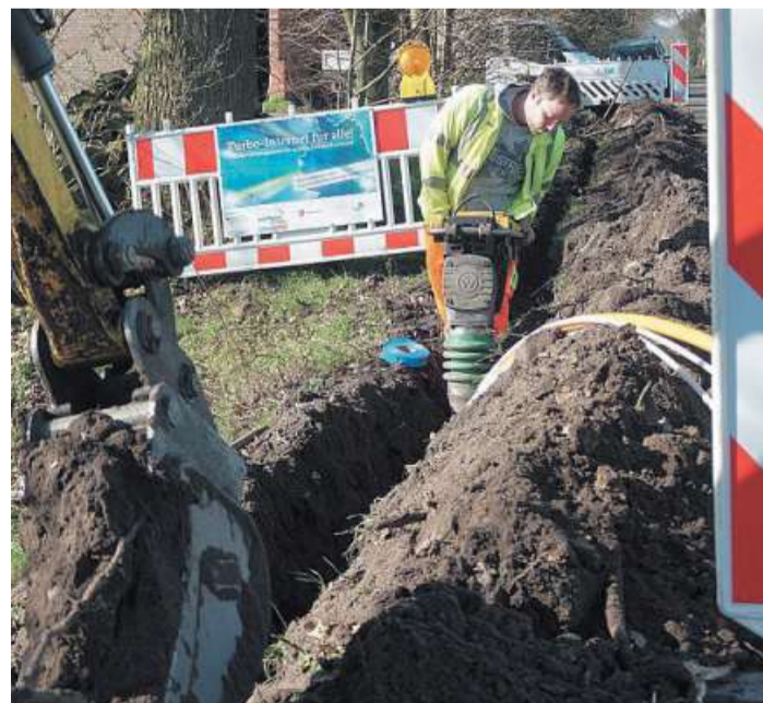
800 km Glasfaser sind bereits verlegt. Jetzt werden die letzten Strecken und Anschlüsse im Förderprojekt fertiggestellt. Foto: priv.
