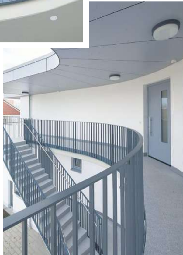
Auf ein innen liegendes Treppenhaus konnte bei dem Neubau verzichtet werden. Fotos: Architekturbüro D. Kaminski
