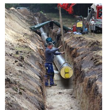
Die ersten 500 Meter der Leitung waren Ende August verlegt.
