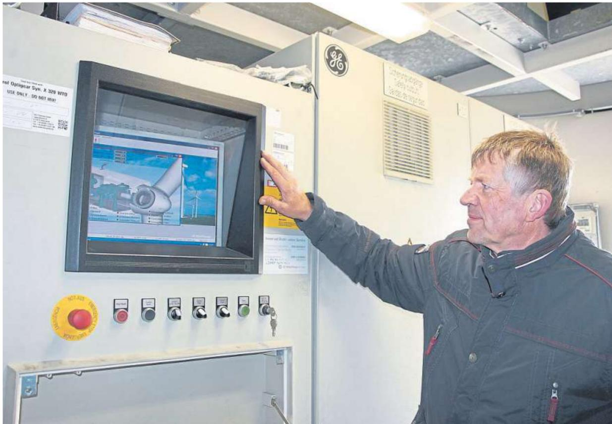
Der Monitor im Inneren des Windrades gibt unter anderem Auskunft über Windstärke und produzierte Kilowattstunden. Insgesamt werden ständig etwa 100 Parameter nach Osnabrück übermittelt. Von dort wird die Anlage online gewartet. FOTO: HAGEBÖLLING
