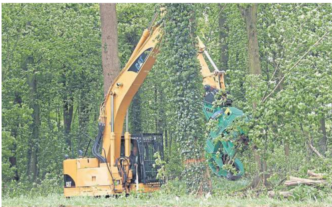
Unter Zuhilfenahme eines Baggers wurden in der ersten Wochenhälfte an der B 214 zwischen Erichshagen-Wölpe und Steimbke zahlreiche umsturzgefährdete Bäume gefällt. Im Vorfeld war jeder einzelne Baum in Augenschein genommen und entsprechend markiert worden.
