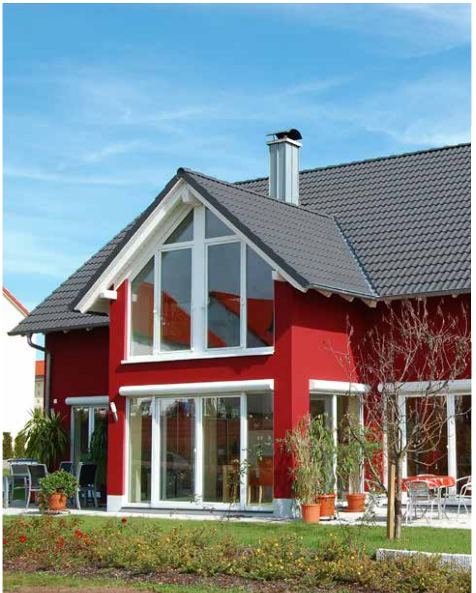
Großes, rotes Glashaus mit neuem Dach.
