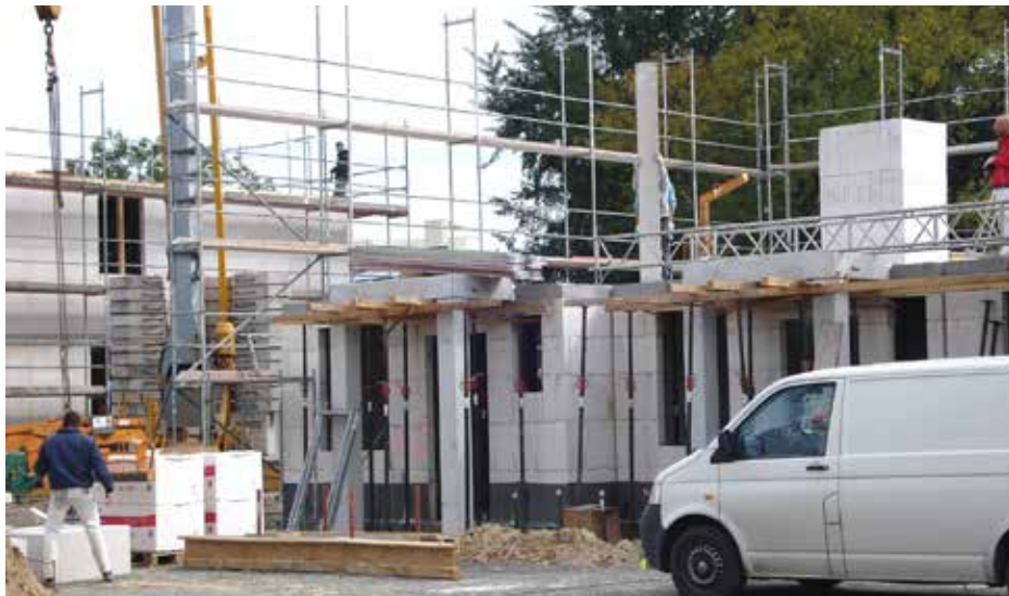
Errichtung von Neubauten mit Betonsteinen.
