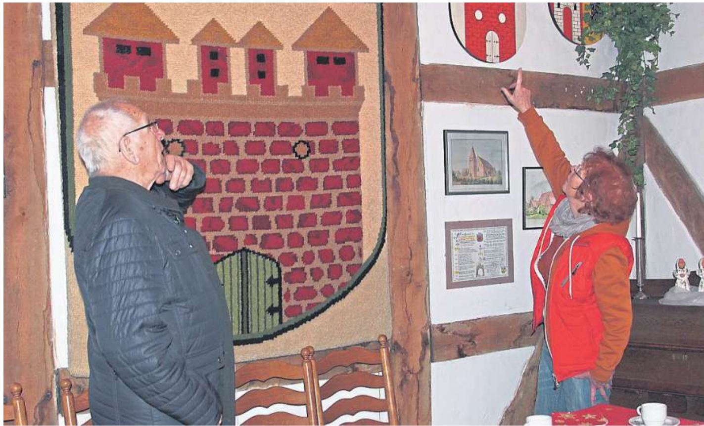
Auch das Fachwerk muss neu verputzt werden. Evelyn Gloggner und Horst Nauck gehen davon aus, dass auf den Heimatverein Drakenburg mit der Sanierung der Olen Schöne eine Menge Arbeit zukommen wird.
