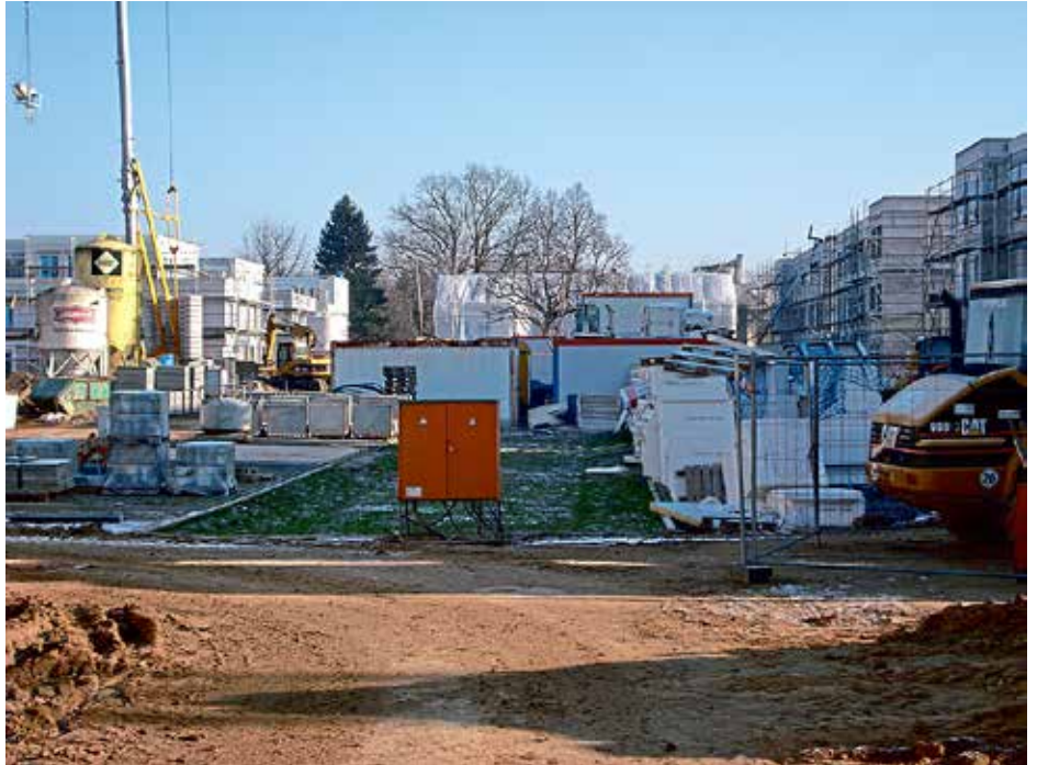
Neue Eigenheime entstehen.
