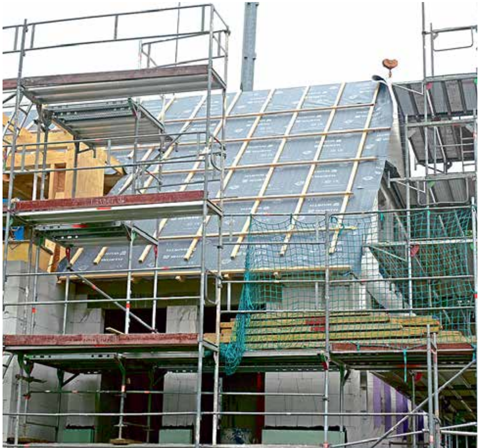
Errichtung eines Wohnhauses.
