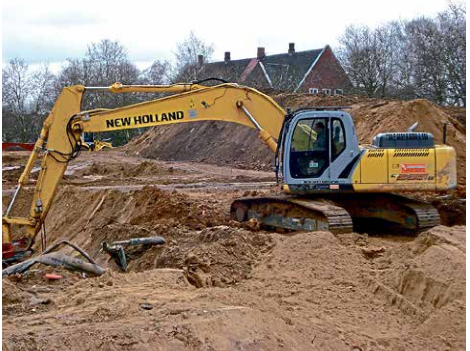
Aushub einer Baugrube.
