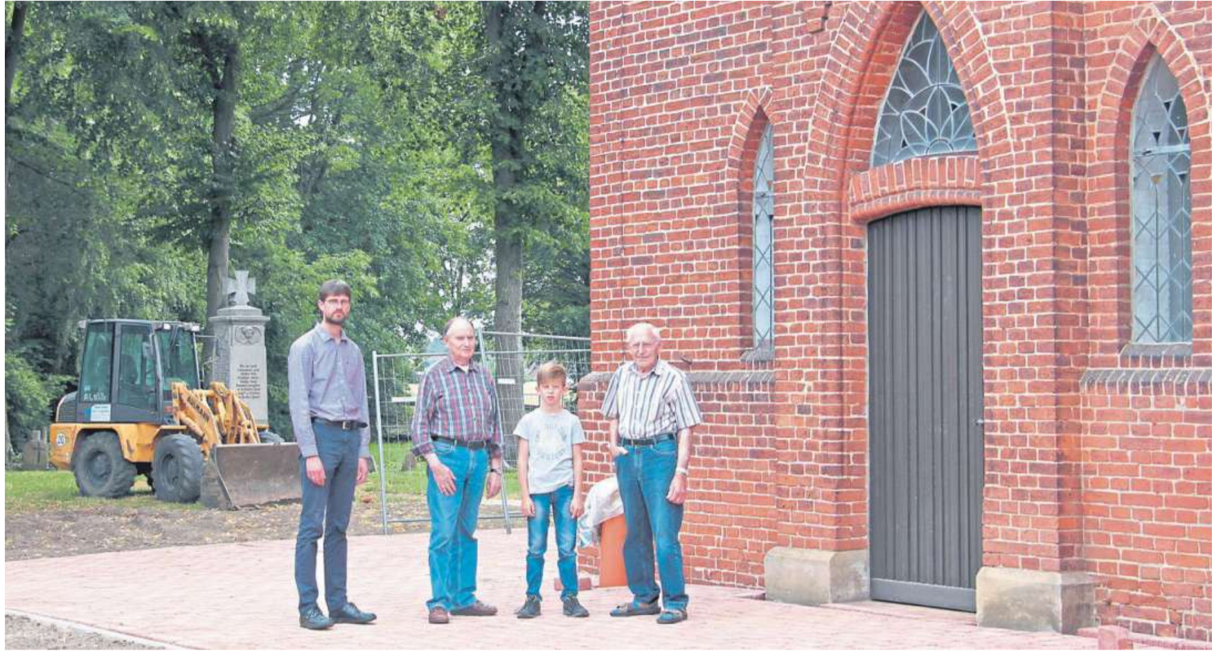
Jetzt sind auch die Außenanlagen so gut wie fertig. Heemsens Pastor Dietmar Hallwaß mit Bauleiter Christian Labrenz, dessen Enkel Vinzenz und Küster Friedrich Burdorf am östlichen Seiteneingang der St.-Michaelis-Kirche.
