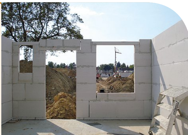
Auf der Baustelle.
