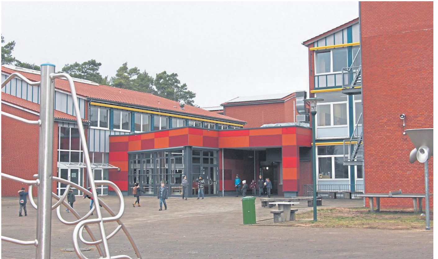
Wo sich viele Jahre Heemsens Haupt- und später Oberschüler in den Pausen tummelten, verbringen jetzt die Grundschüler ihre freie Zeit. Bis zum Sommer sollen auch die große Sandkiste und die Rutsche fertig sein. FOTO: HAGEBÖLLING
