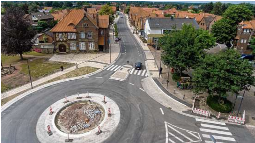
Die Sanierung der Rehburger Ortsdurchfahrt mit Kreisel-Bau dauerte 15 Monate. Foto: Schwiersch
