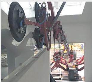
Ein Minikran, der zum Einsetzen von Glasscheiben genutzt wird.
